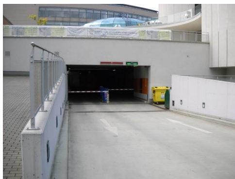
Obrázek 17 – vjezd do podzemních garáží pod KC. [77]
